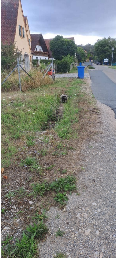
Bild: Straßenentwässerungsgraben Blick Ortseinwärts
