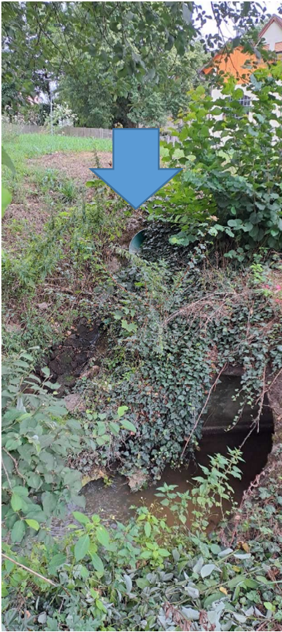
Bild : Auslauf Oberflächenwasserkanal (Pfeil)
